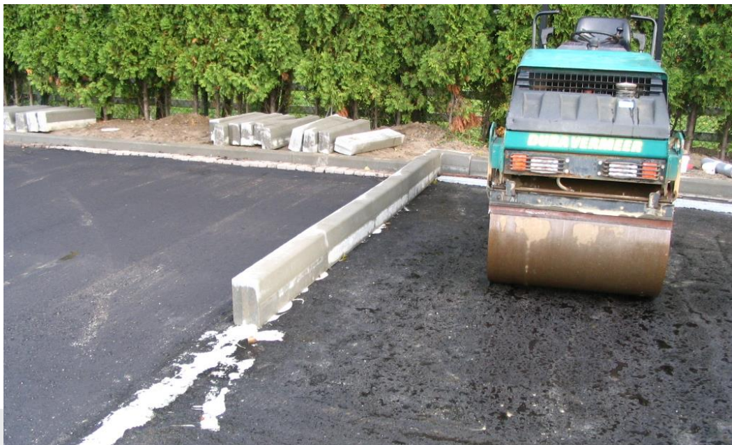
Foto: Verdichten van het asfalt
