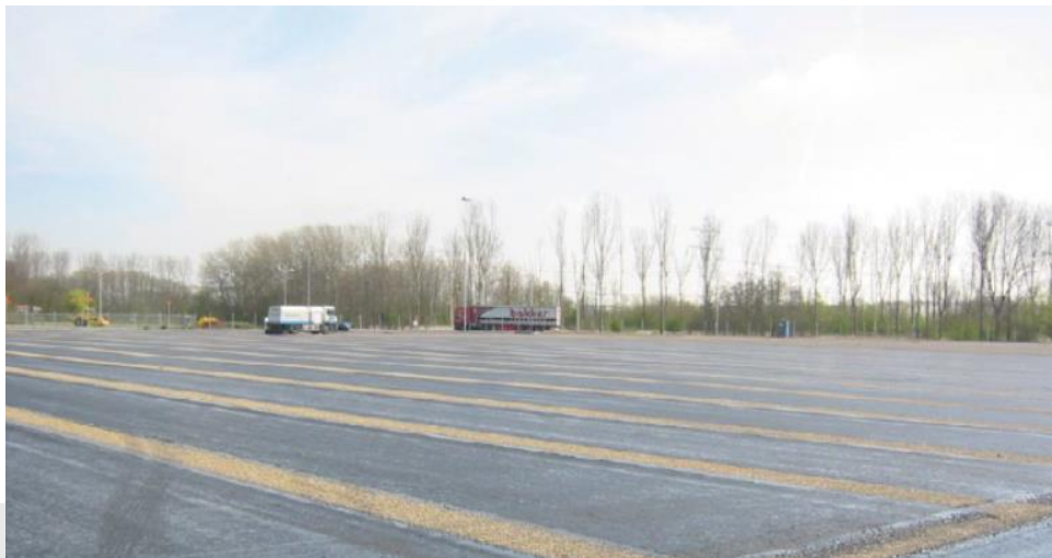
Foto: Aanleg vloeistofdichte asphaltconstructie (bron: VBW Handleiding vloeistofdichte bitumineuze constructies).
