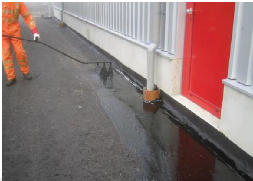
Foto: Aanbrengen bitumineus membraan (bron: VBW Handleiding vloeistofdichte bitumineuze constructies).
